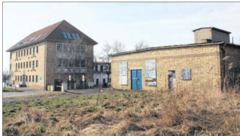
Hafen Karlshagen: Das alte Kühlhaus (r.) neben dem Restaurant „Veermaster“ soll abgerissen werden. Foto: Henrik Nitzsche
